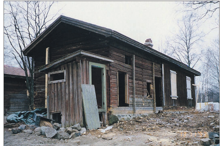
Piharakennus saneeraustöiden alkaessa. Valokuva: Kyösti Koponen.
