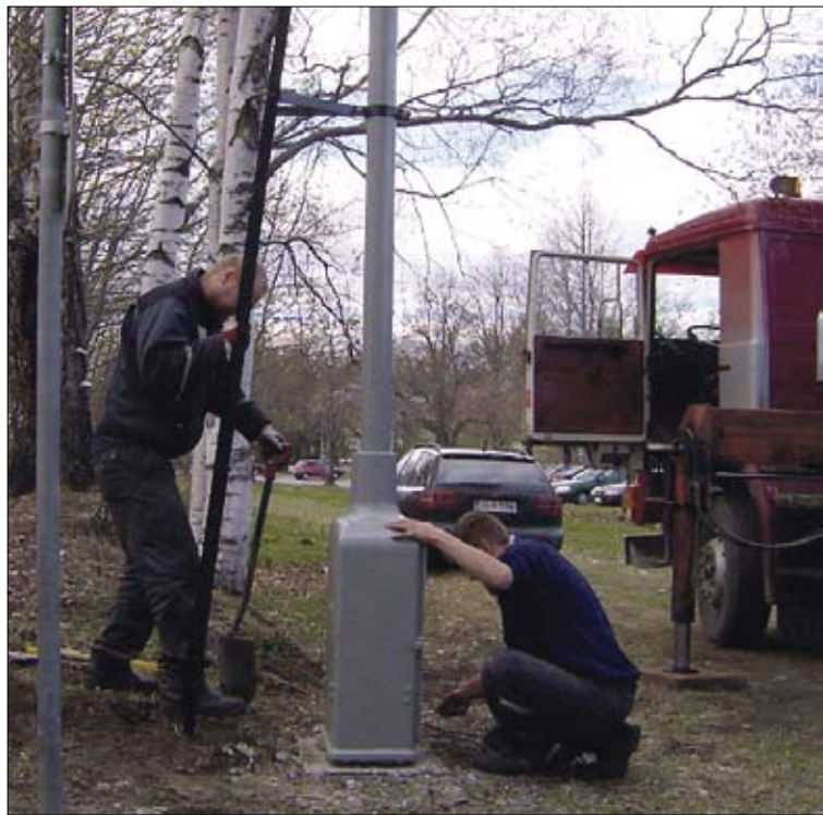
Kuvassa JOT Asennus Oy:n miehet asentamassa opastinta.
