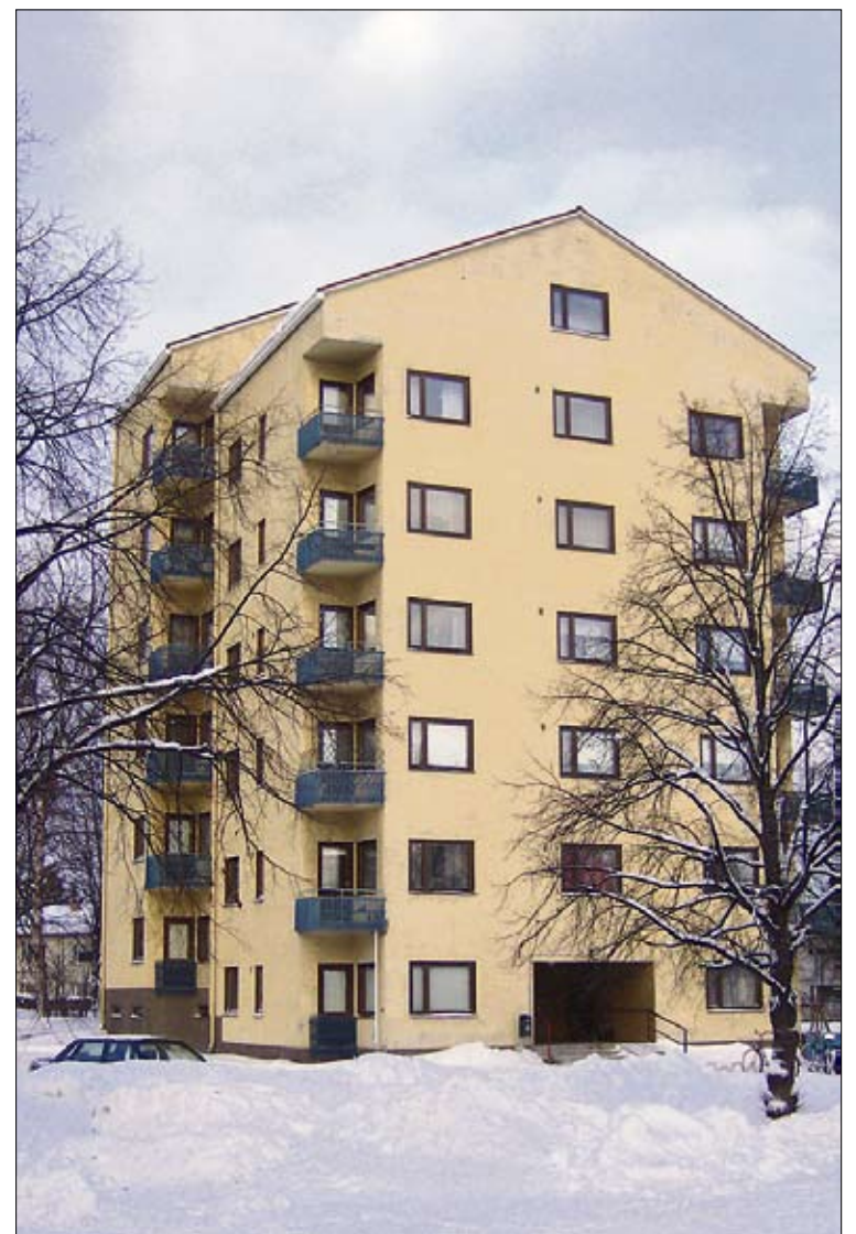
Vanha Pistetalo saneerattuna.
